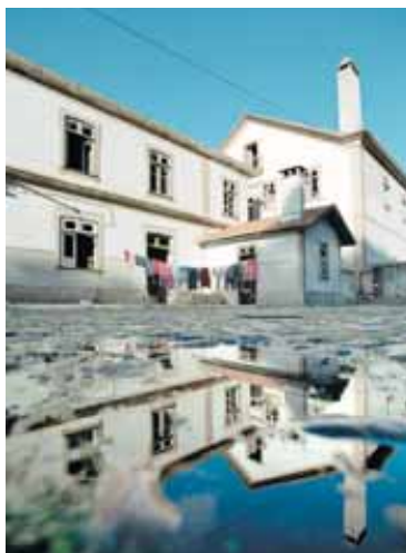
Barca de Alva, estação transfronteiriça em abandono
