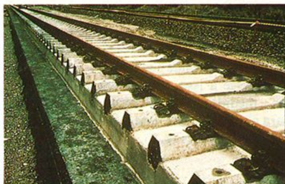
Via férrea permanente Rheda — Oelde Fig. 4
