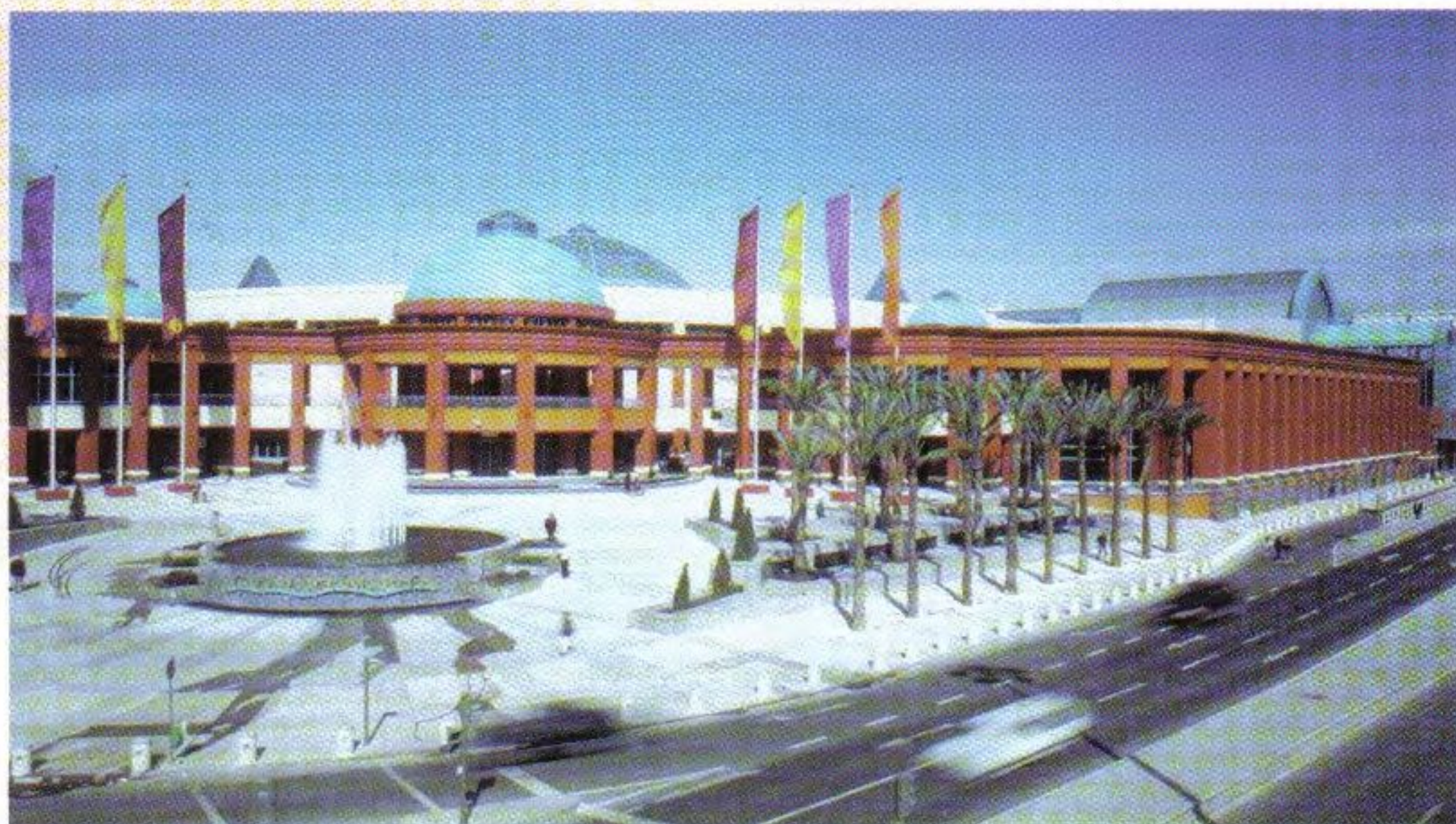
Sistema Integrado de Gestão Técnica (Centro Colombo)
