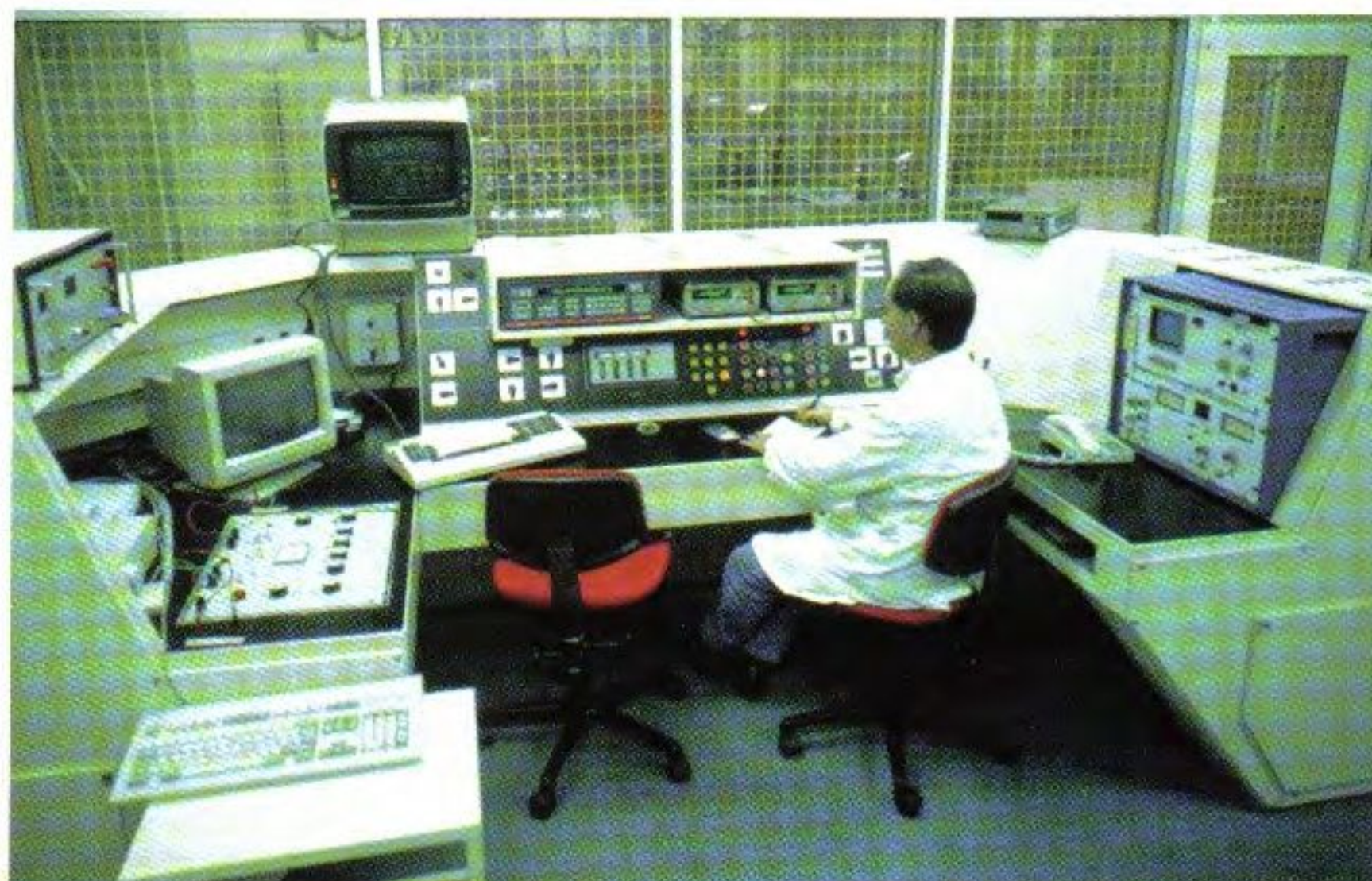
Laboratório de transformadores de potência
