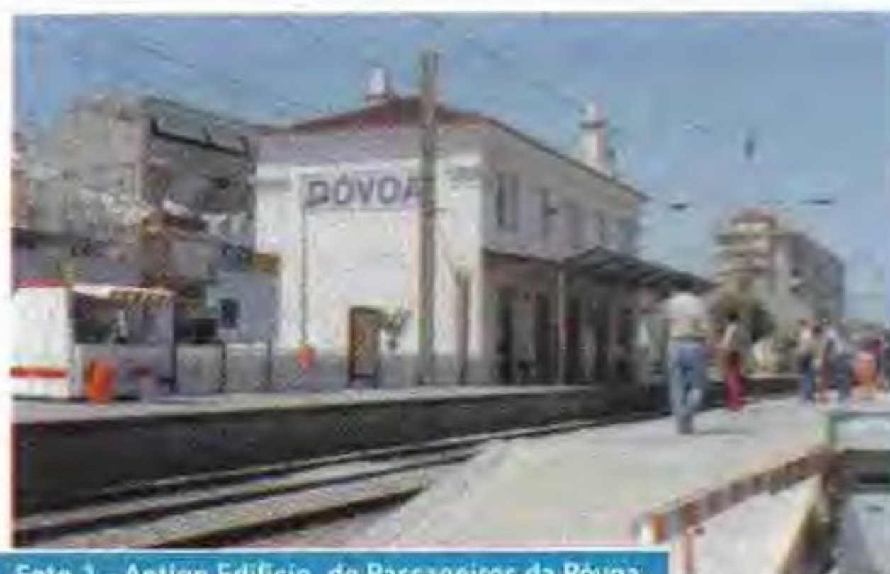
Foto 1 - Antigo Edifício de Passageiros da Póvoa
