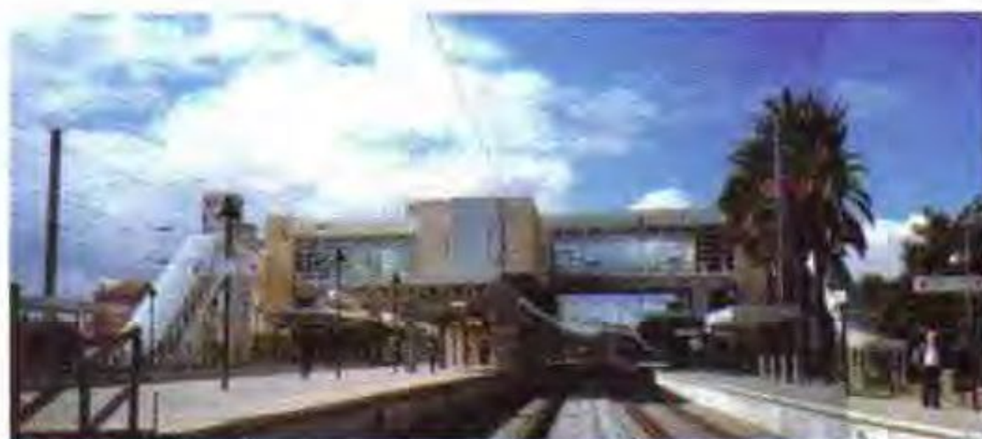
Foto 5 – Vista geral a partir de Norte do novo Edifício de Passageiros da Póvoa
