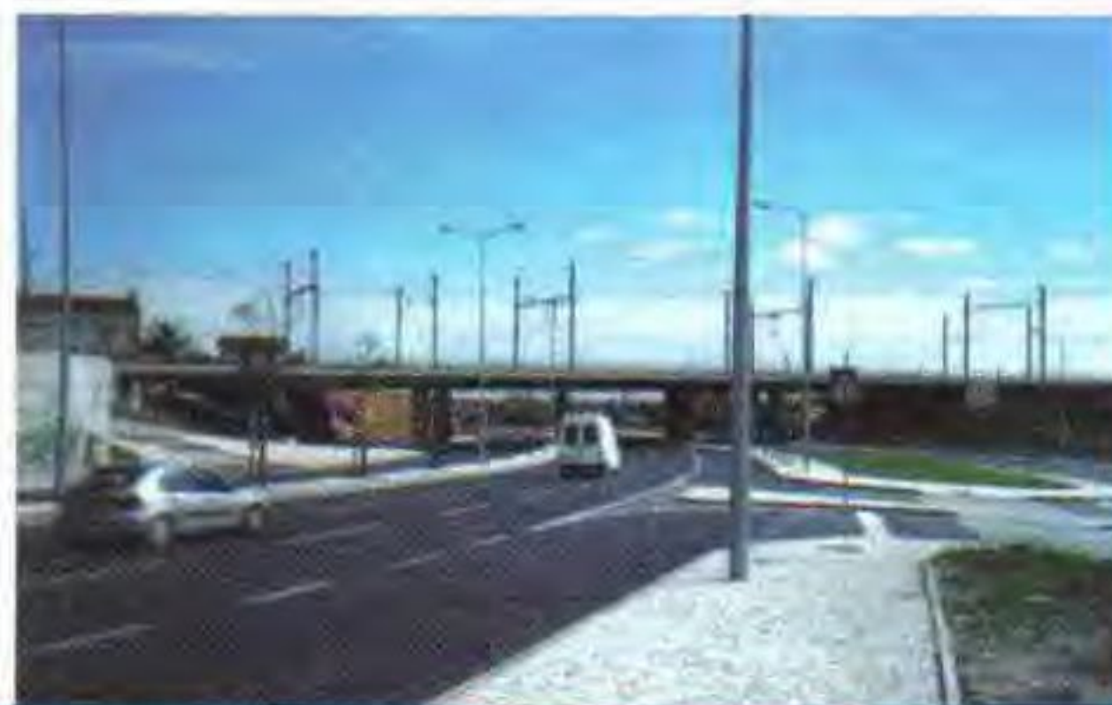
Foto 8 - Vista de Poente do novo viaduto da Av.ª Infante D. Henrique
