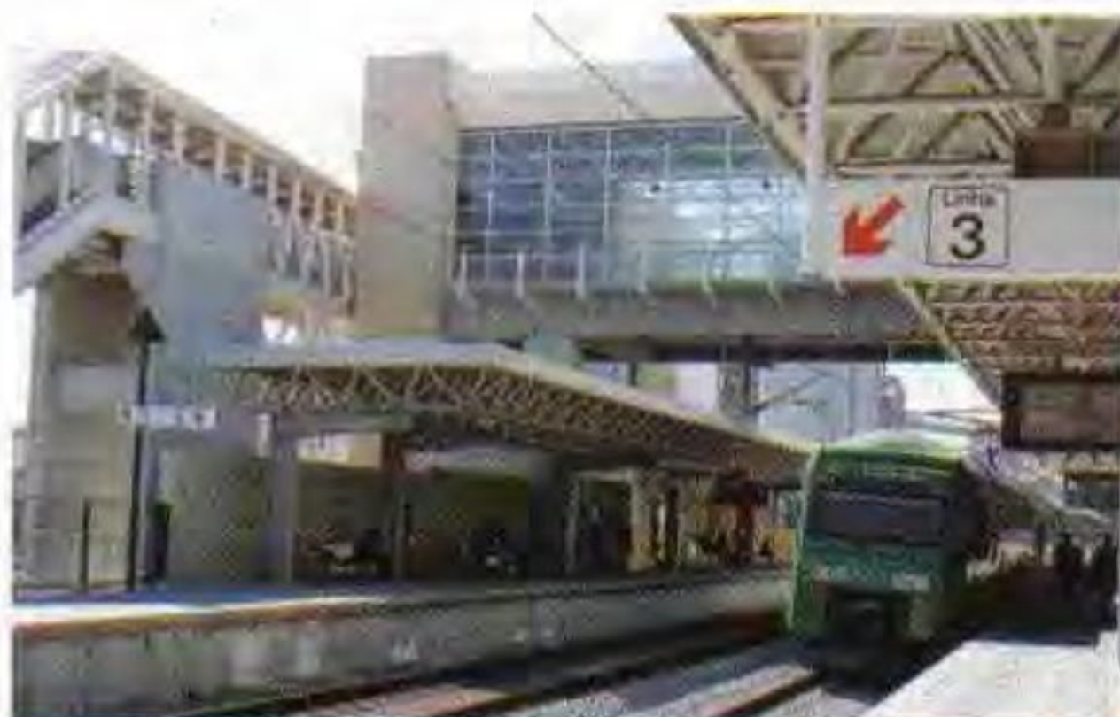
Foto 7 - Vista do lado Nascente do novo Edifício de Passageiros da Póvoa
