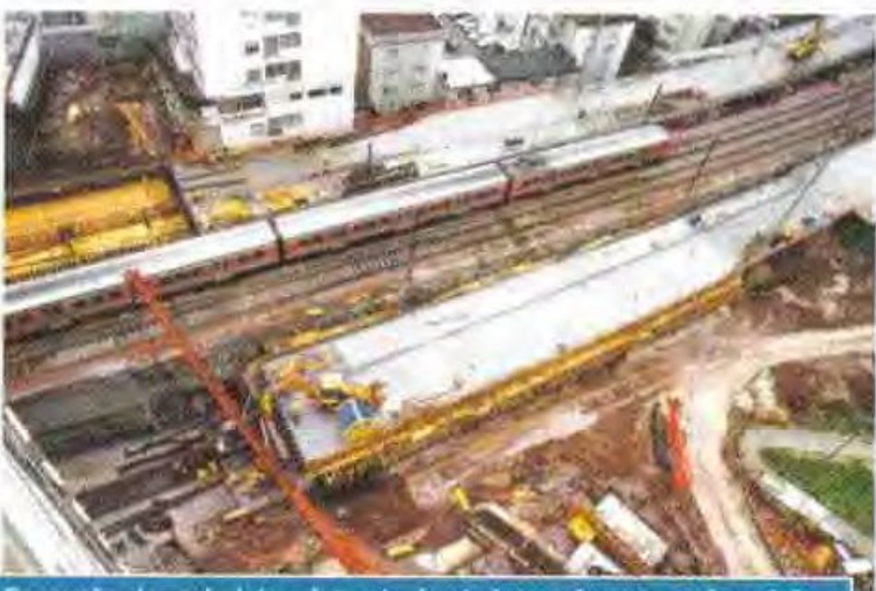
Execução dos tabuleiros laterais do viaduto referentes à fase 1.6
