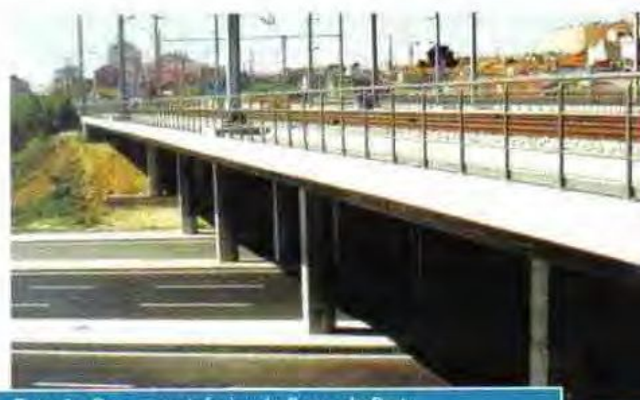
Foto 4 - Passagem Inferior de Braço de Prata
