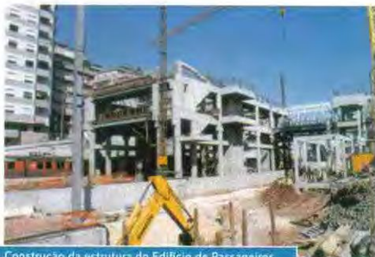
Construção da estrutura do Edifício de Passageiros
