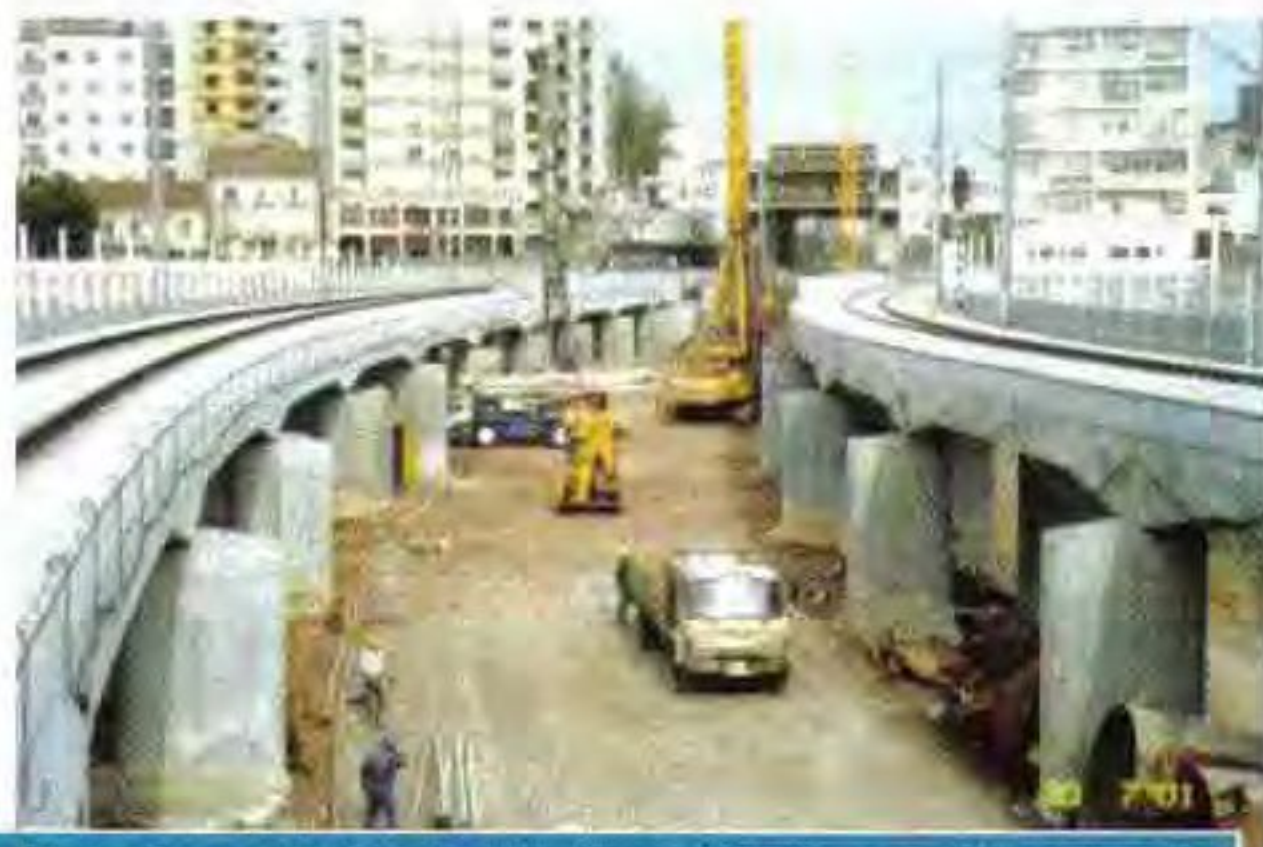
Execução a partir da nova plataforma das estacas e pilares centrais do viaduto referentes à fase 2.2
