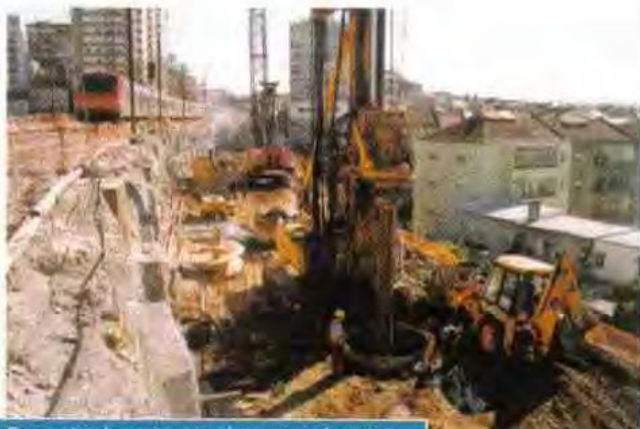
Execução das estacas referentes à fase 1.4
