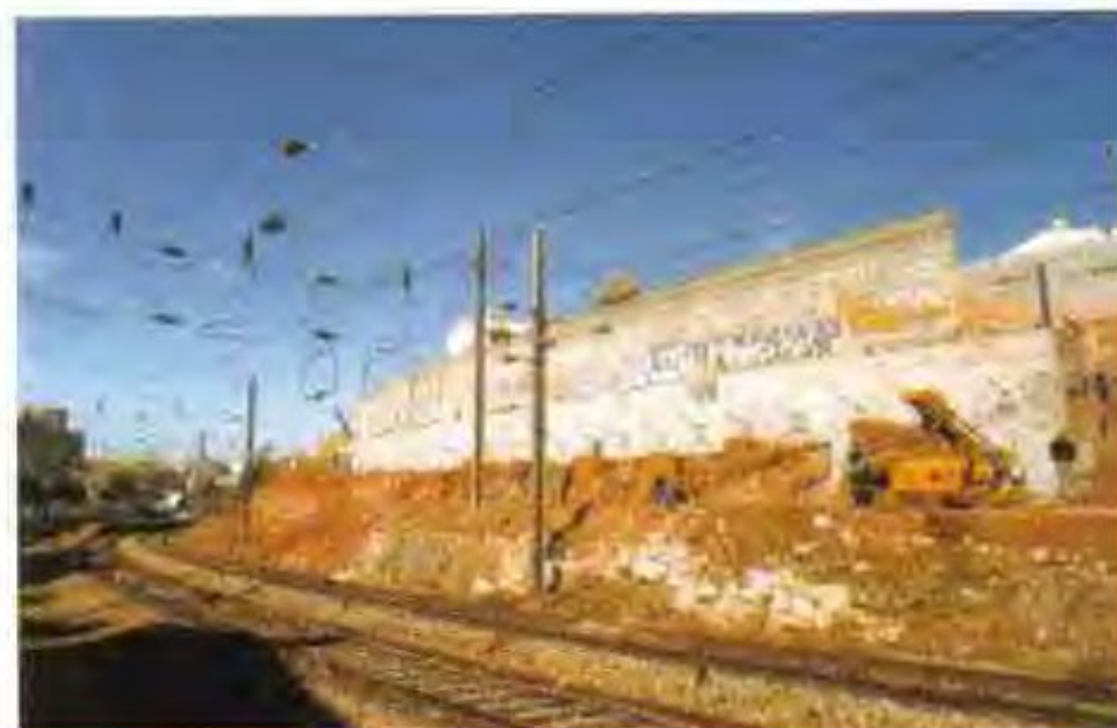
Muros de Suporte tipo Berlim
