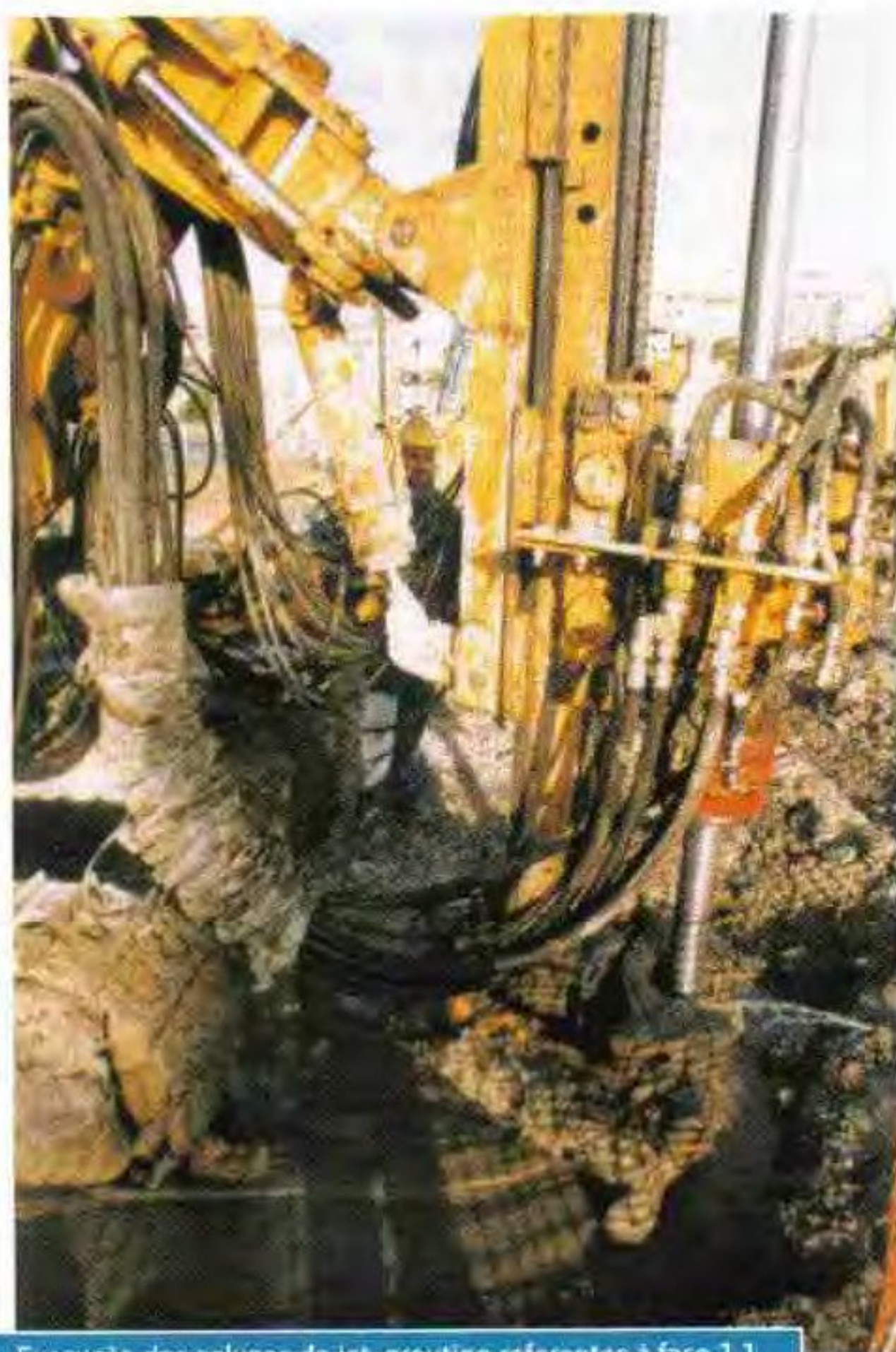
Execução das colunas de jet-grouting referentes à fase 1.1
