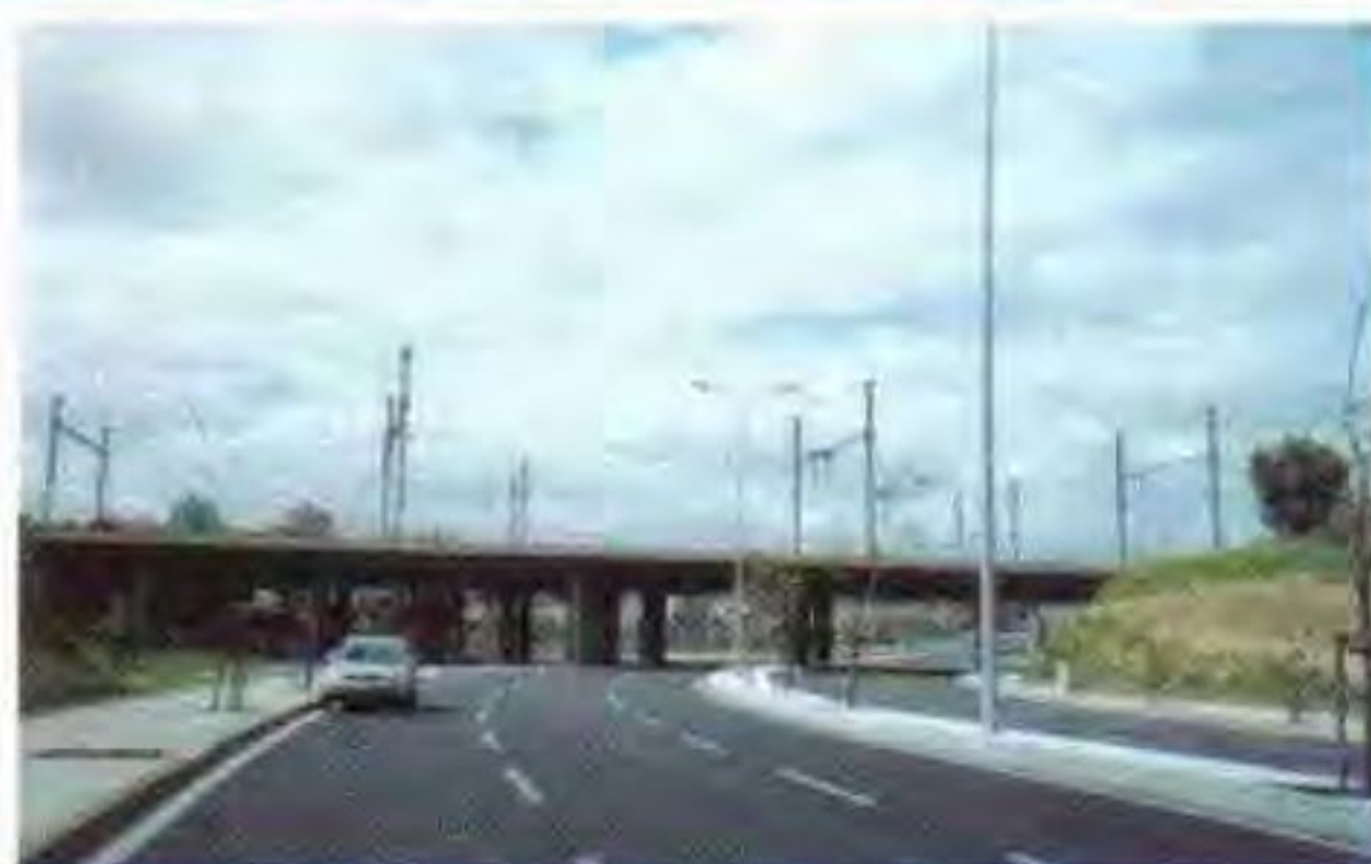
Foto 9 - Vista de Nascente do novo viaduto da Av.ª Infante D. Henrique
