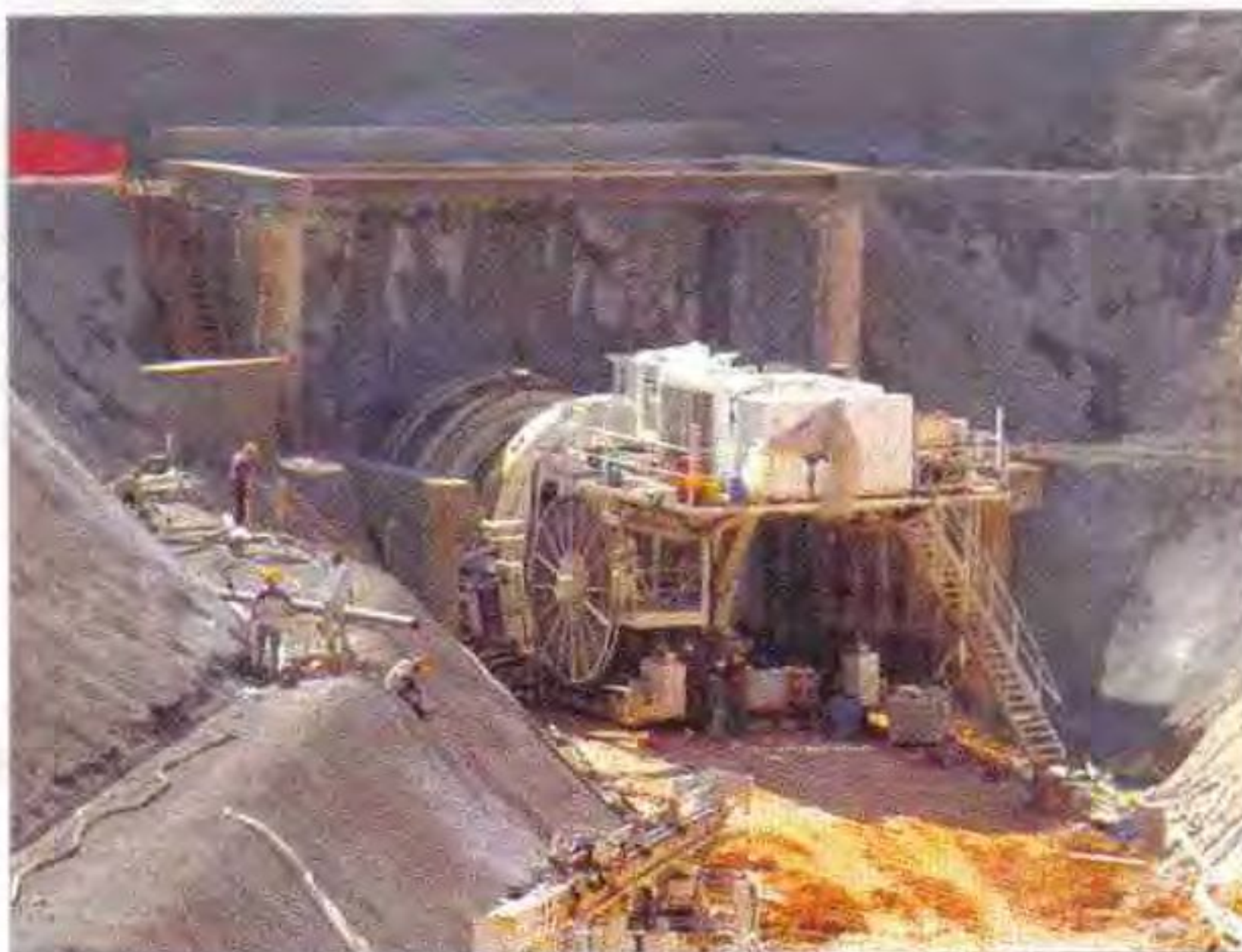
Expansão do Eixo Norte-Sul - Concepção e Construção do Túnel de Penalva
