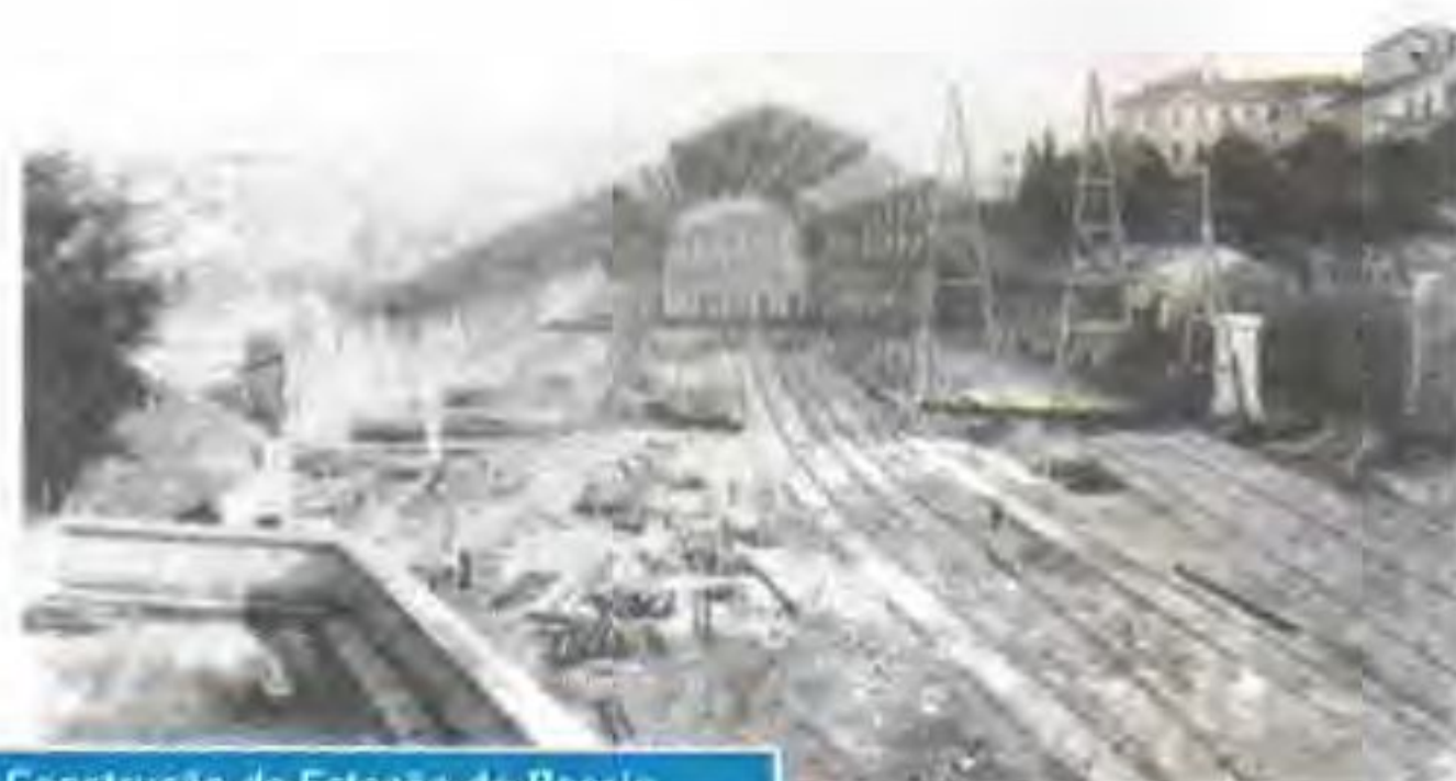
Construção da Estação do Rossio
