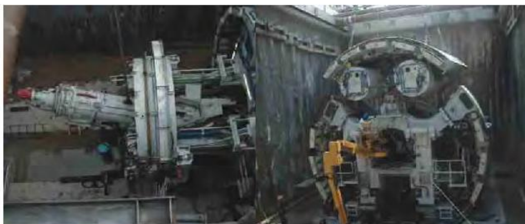
Fase de Montagem da Tuneladora
