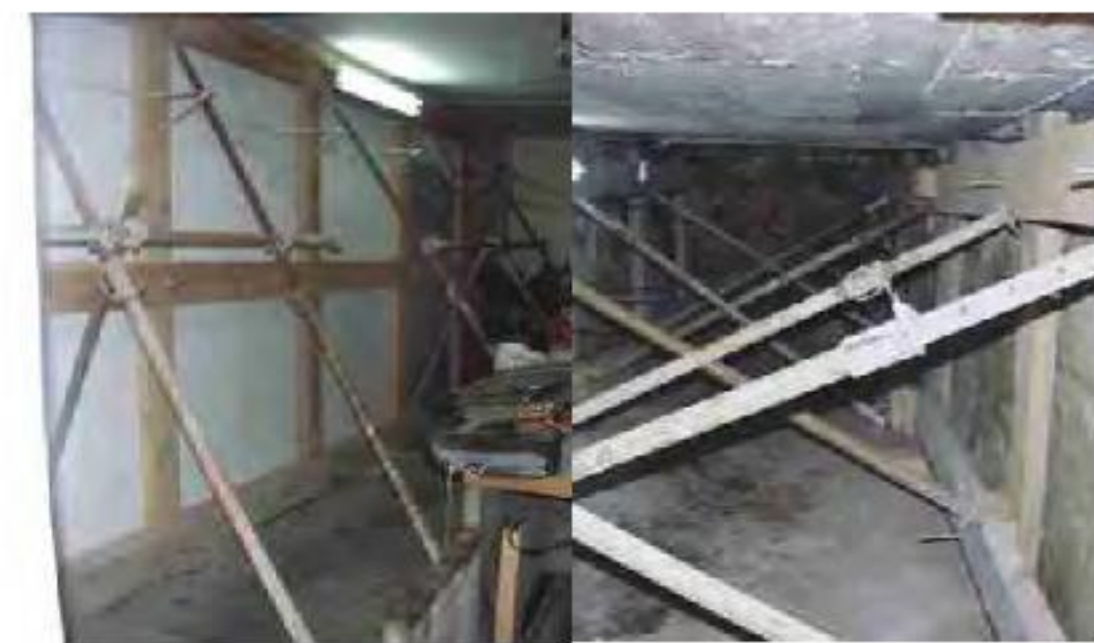
Travamento das Paredes interiores Edifícios Rua do Bonjardim
