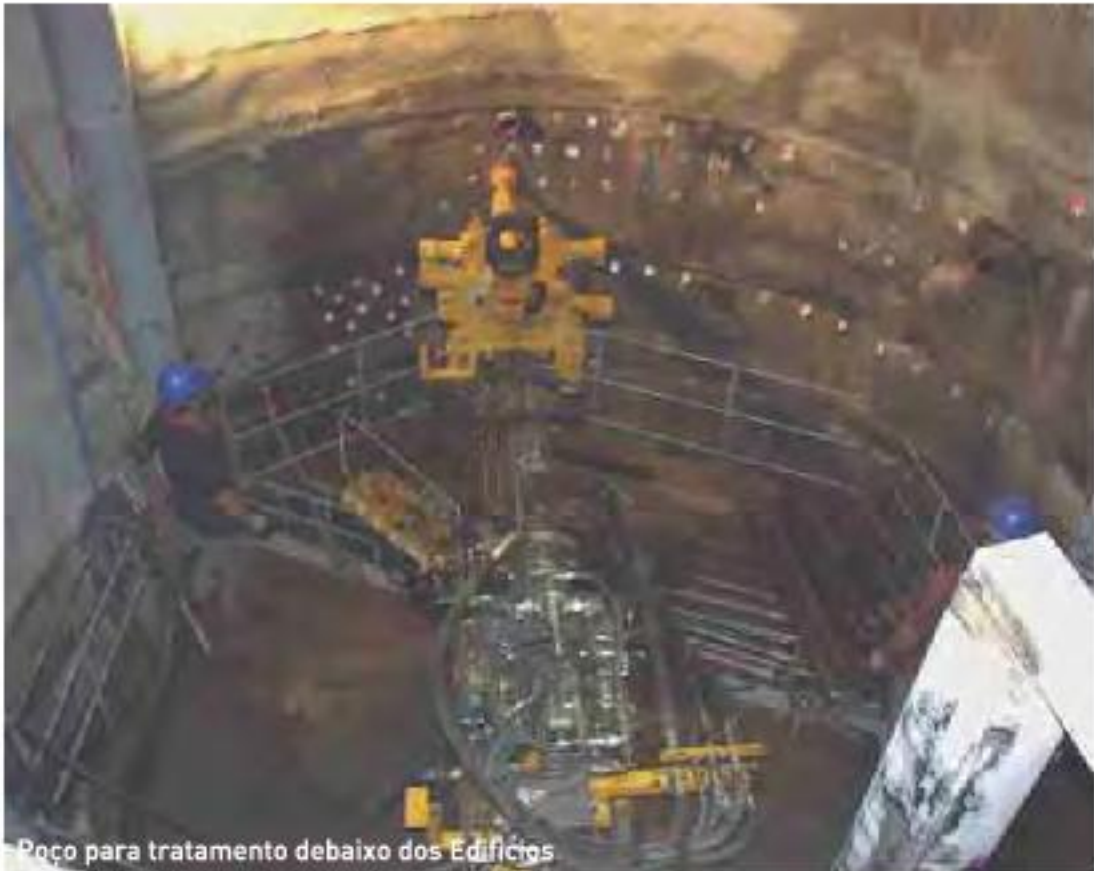
Poço para tratamento debaixo dos Edifícios
