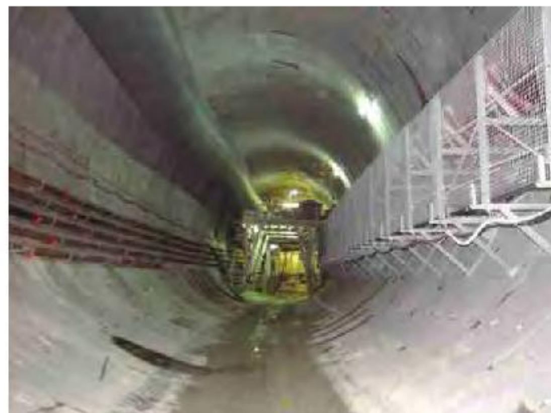
Vista do interior do Túnel
