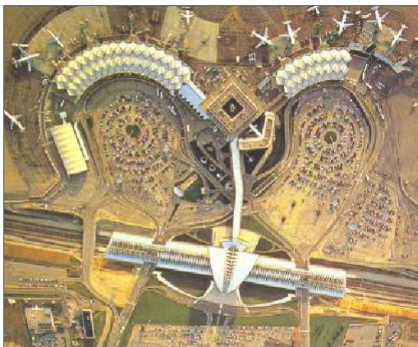
Fig. 16 – Linha de Alta Velocidade Ferroviária (TGV), Paris-Lyon e estação de TGV do Aeroporto de Lyon]
