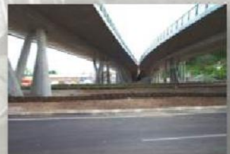
Viaduto de Acesso ao Fórum Coimbra
