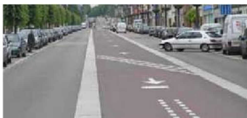
Pormenor da marcação de alternância de sentido em via única (Rouen - França)
