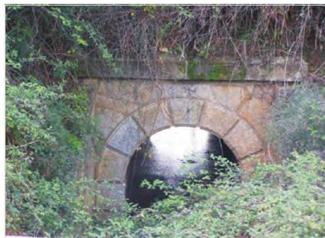
Fig.5 - Passagem hidráulica existente no troço entre a Estação de Sousel e o Apeadeiro de Santo Amaro-Veiros
