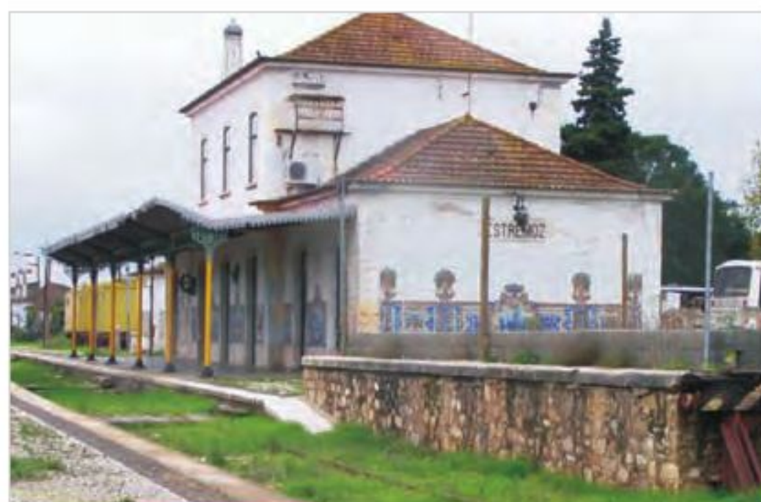
Fig. 7 - Estação de Estremoz Edifício de passageiros e habitação.
