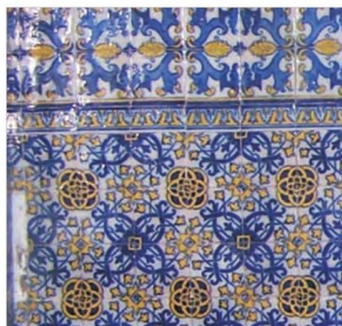
Fig.14 - Estação de Estremoz Painéis de azulejos existentes, do lado interior.
