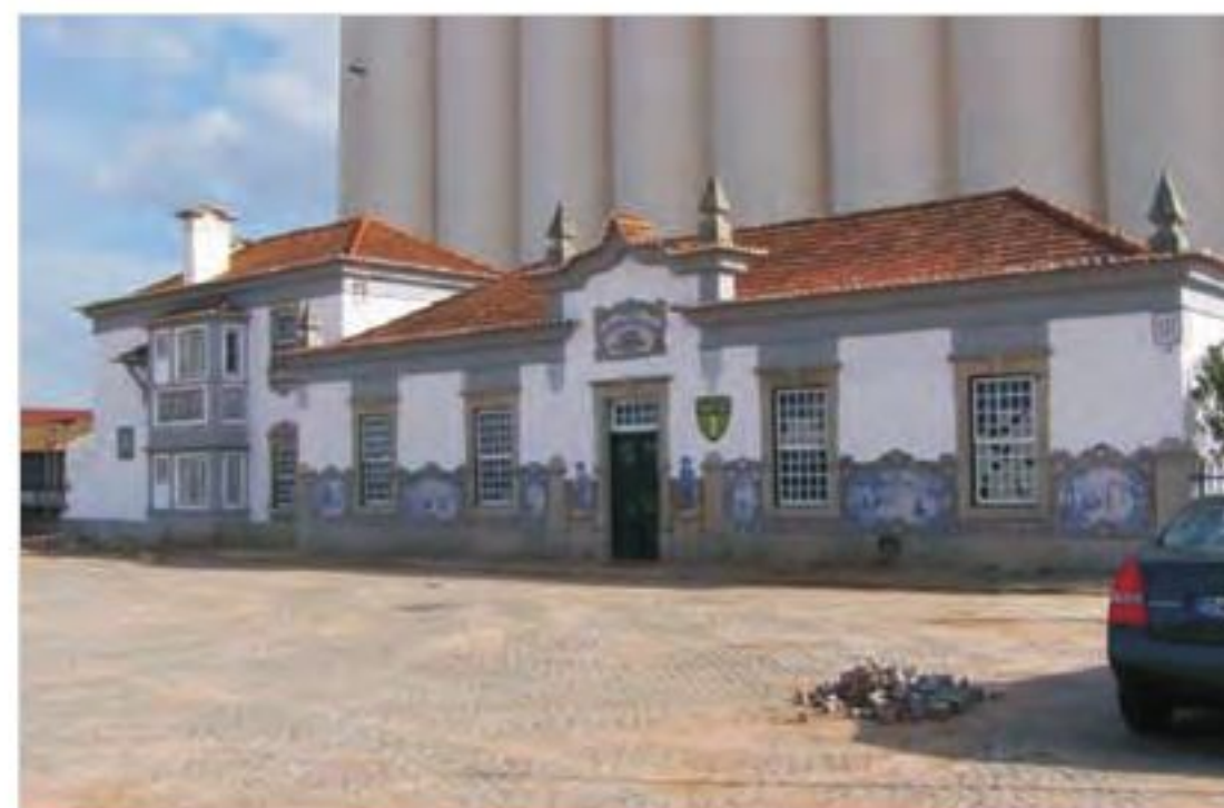
Fig. 9 - Estação de Fronteira Edifício de passageiros e de habitação.
