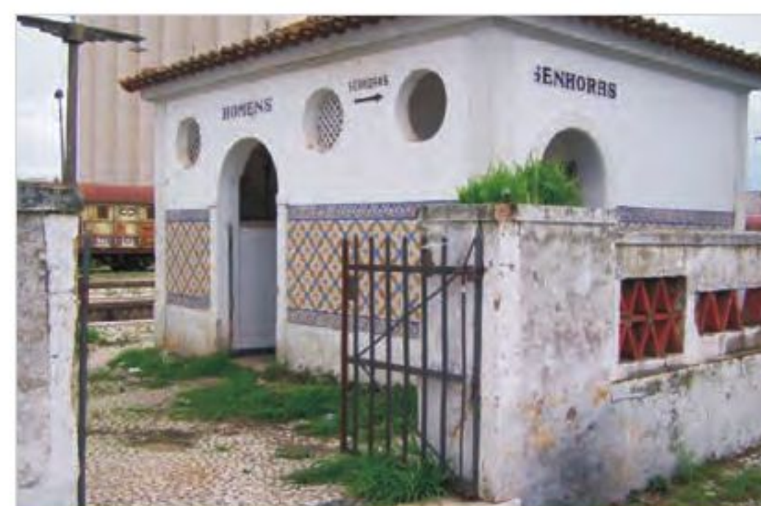
Fig.20 - Estação de Estremoz. Instalações sanitárias.
