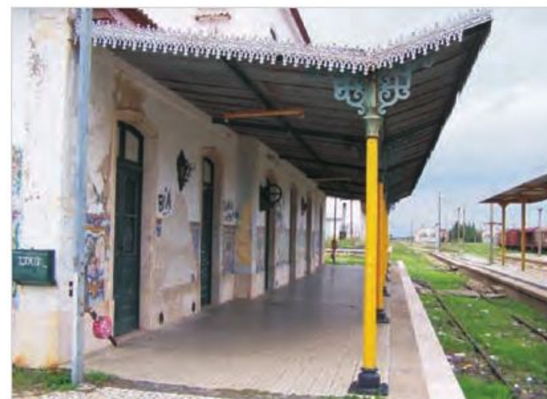
Fig.18 - Estação de Estremoz Cobertura da plataforma de passageiros.
