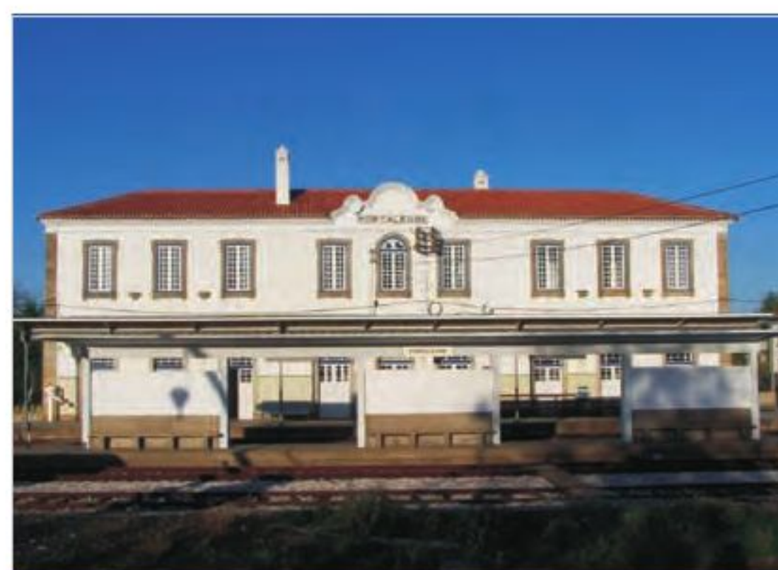
Fig. 11 - Estação de Portalegre Edifício de passageiros e de habitação.
