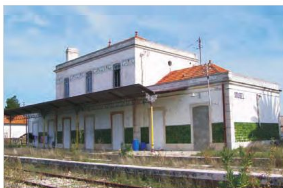
Fig. 8 - Estação de Sousel Edifício de passageiros e habitação.
