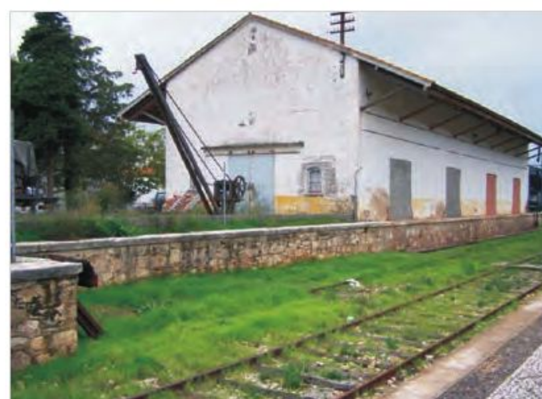
Fig.23 - Estação de Estremoz Cais coberto de mercadorias com grua de apoio.
