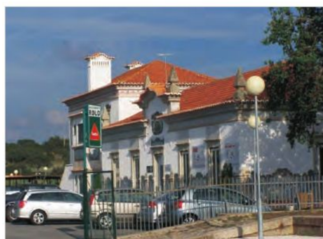
Fig. 10 - Estação de Cabeço de Vide Edifício de passageiros e de habitação.
