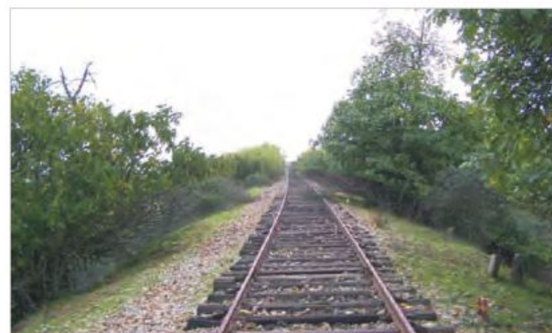
Fig.2 - Trecho de via junto à Estação de Estremoz.
