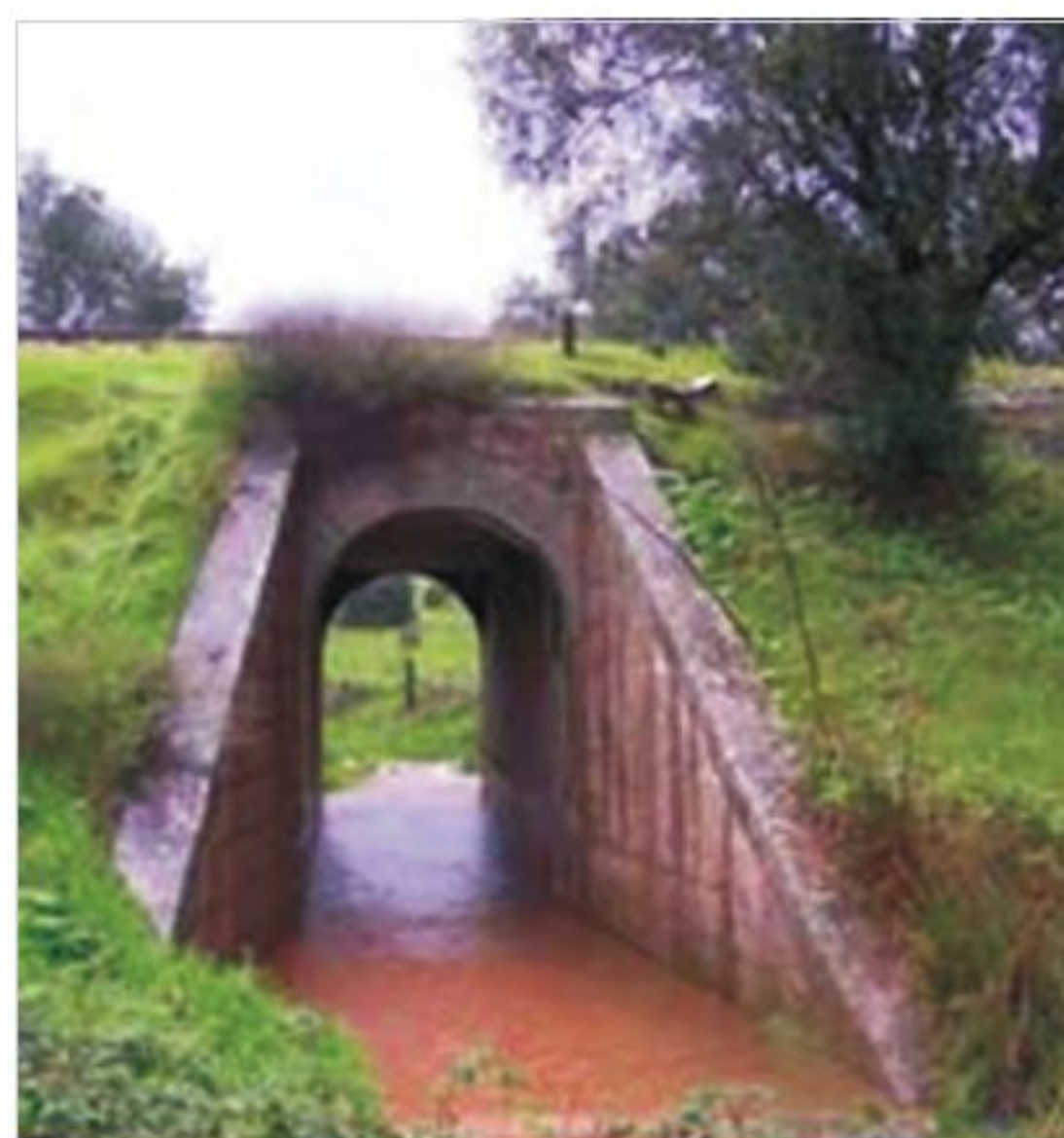
Fig.6 - Passagem Hidráulica existente no troço entre Apeadeiro de Coutos e a Estação de Cabeço de Vide.
