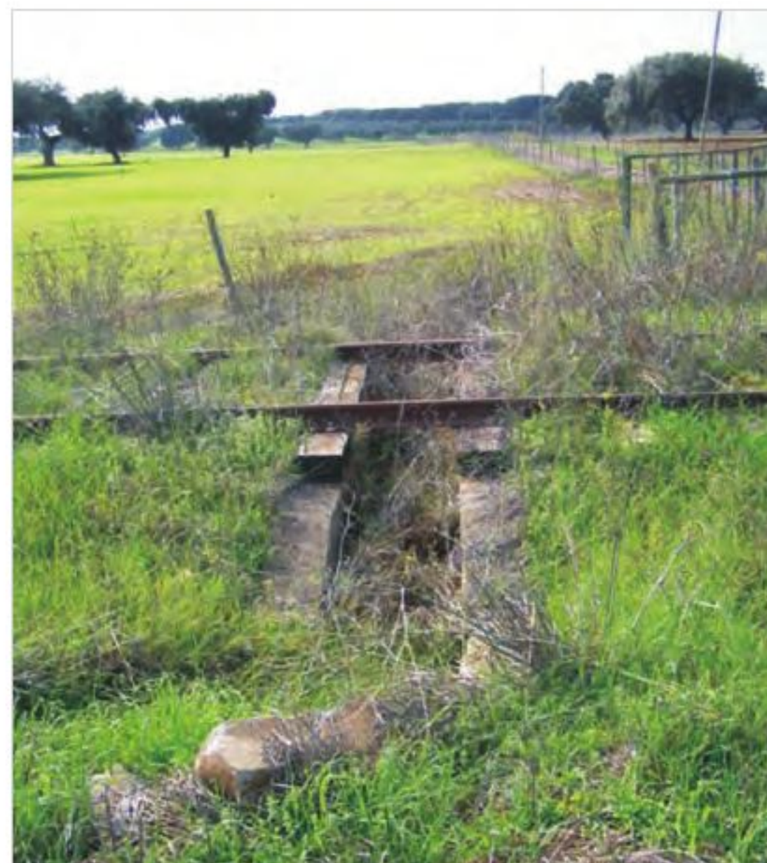
Fig.4 - Passagem hidráulica existente no troço entre a Estação de Sousel e o Apeadeiro de Santo Amaro-Veiros
